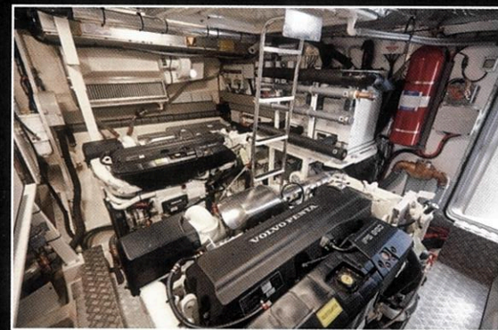
La salle des machines, avec les deux IPS 950, comprend tout l'équipement technique, du dessalinisateur au groupe électrogène.
